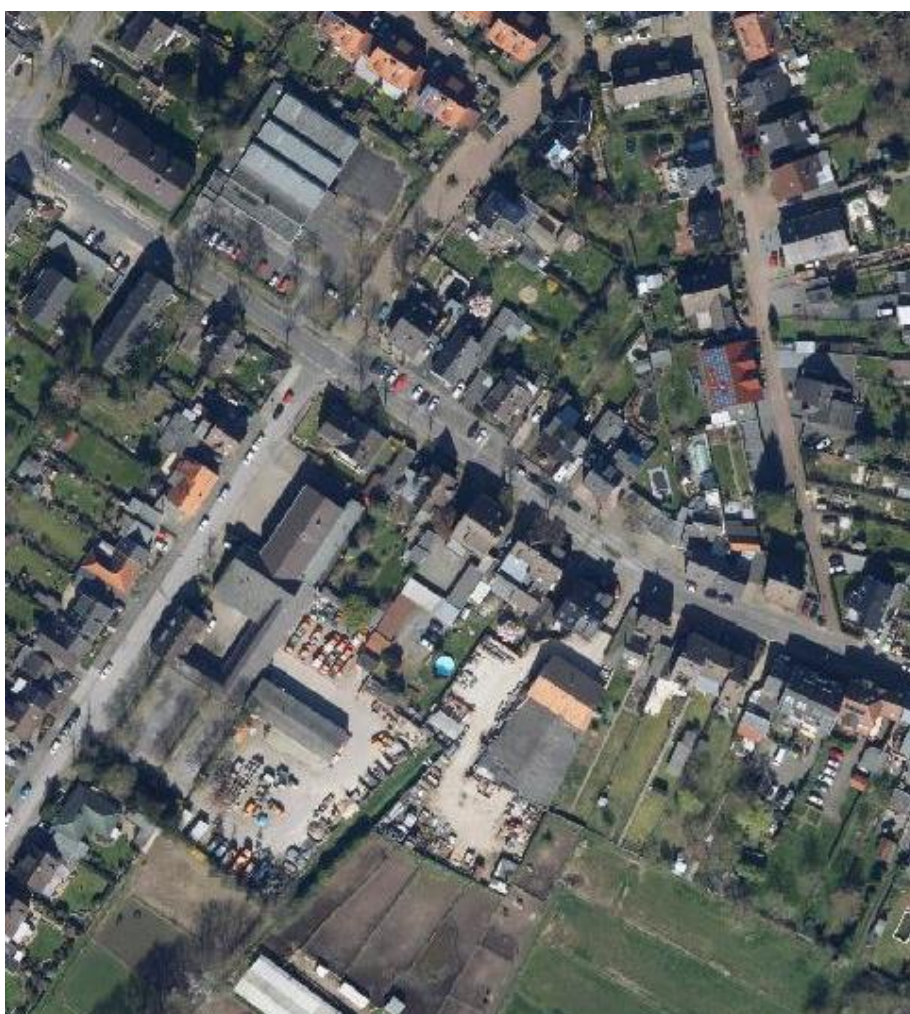
Abbildung 4: Luftbild des Untersuchungsraums (Quelle: GeoMedia/KRZN)
